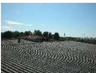
La copertura in cemento amianto
