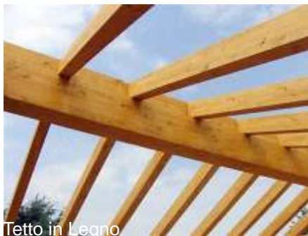
Tetto in Legno
