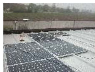
Il montaggio dei moduli PV
