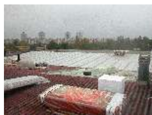
La rimozione del cemento amianto
